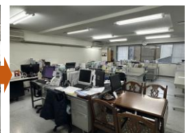
執務室の書類棚撤去
